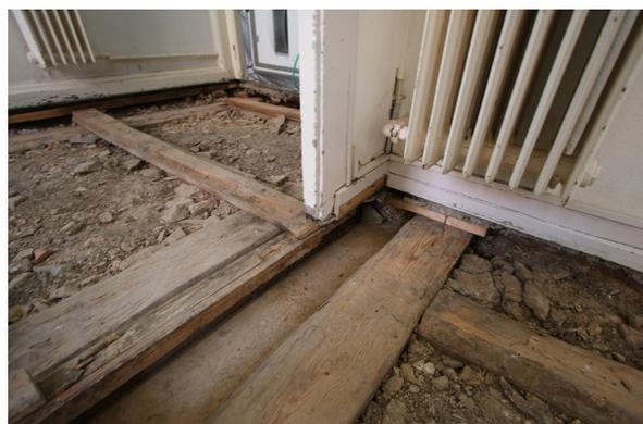
Fig. 19: Scorie per isolante di riempimento
