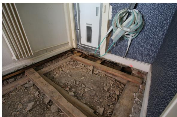
Fig. 20: Scorie per isolante di riempimento
