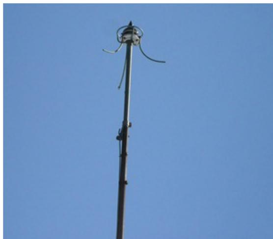
Fig. 9: Parafulmine con Ra-226
