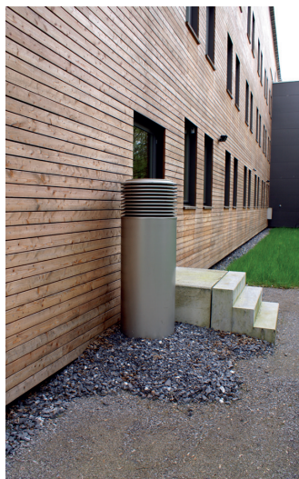
Presa d'aria per una ventilazione controllata della zona abitativa (almeno 80 cm dal suolo)
