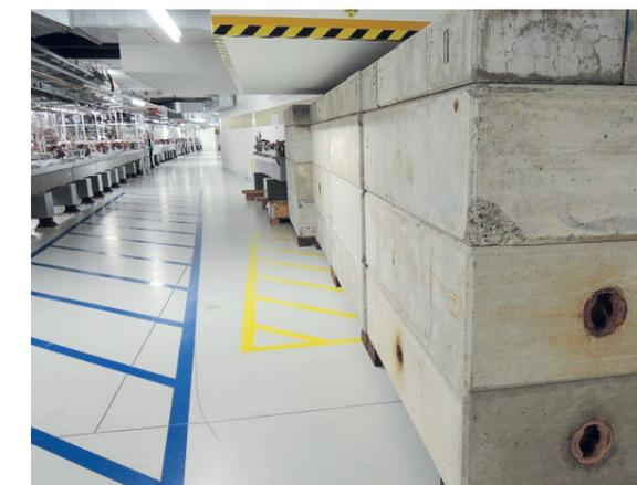
Fig. 12 : Blindage utilisé dans le tunnel contre les rayonnements ionisants
