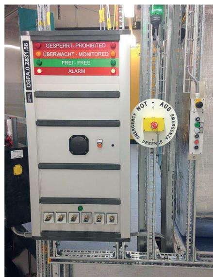
Fig. 11 : Système à clés assurant la sécurité des personnes à l'une des entrées du tunnel
