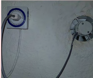
Réduction excessive du débit ou fonctionnement limité sur minuterie
