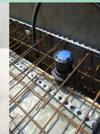
Utilisation de manchons et joints étanches pour les traversées de murs et dalles en contact avec le terrain
