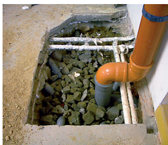
Ventilation ponctuelle (puisard à radon) – Excavation d'un puits
