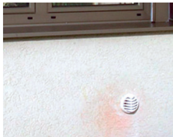
Un apport contrôlé d'air frais crée une légère surpression dans le local / le bâtiment (vues intérieure et extérieure)
