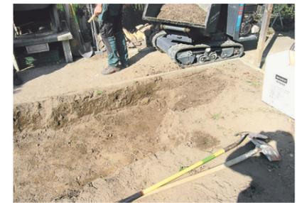
Abb. 19 : Sanierung eines mit Radium belasteten Gartens
