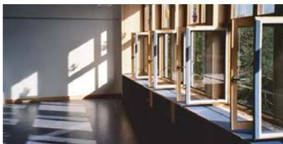
*La rénovation des revêtements d'allèges et des fenêtres ont conduit à des teneurs en formaldéhyde trop élevées dans l'air, à des plaintes et enfin à la fermeture du bâtiment.*
