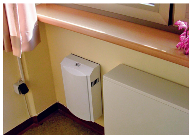
L'aerazione controllata genera una leggera sovrappressione nel locale/edificio (interno ed esterno)
