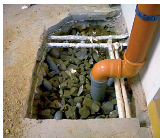
Aspirazione puntuale (pozzo radon) – scavo di un pozzetto.
