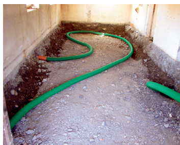
Rinnovo della sottostruttura del pavimento: impianto di un sistema di drenaggio del radon.
