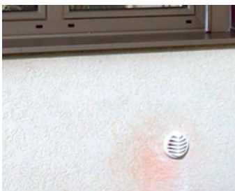
L'aerazione controllata genera una leggera sovrappressione nel locale/edificio (interno ed esterno)
