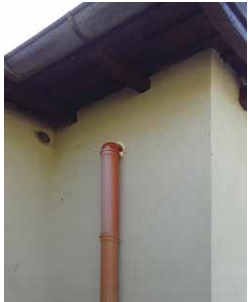
Figura 6.23: Per ragioni di spazio e per prevenire rumori nella zona notte, il tubo di ventilazione è stato installato esternamente all'edificio.
