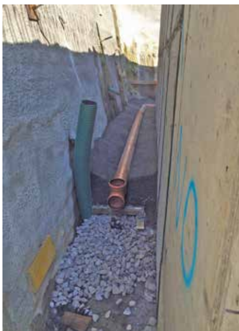
Figura 6.86 (sinistra): Dettaglio del drenaggio radon.
