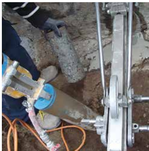
Figura 6.4: Per il pozzo radon esterno è stato eseguito un carotaggio sotto l'edificio.
