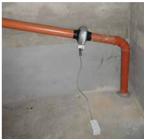
Figura 6.13: Dapprima è stata testata la ventilazione del vespaio. Infine si è deciso di costruire un pozzo radon interno (destra).
