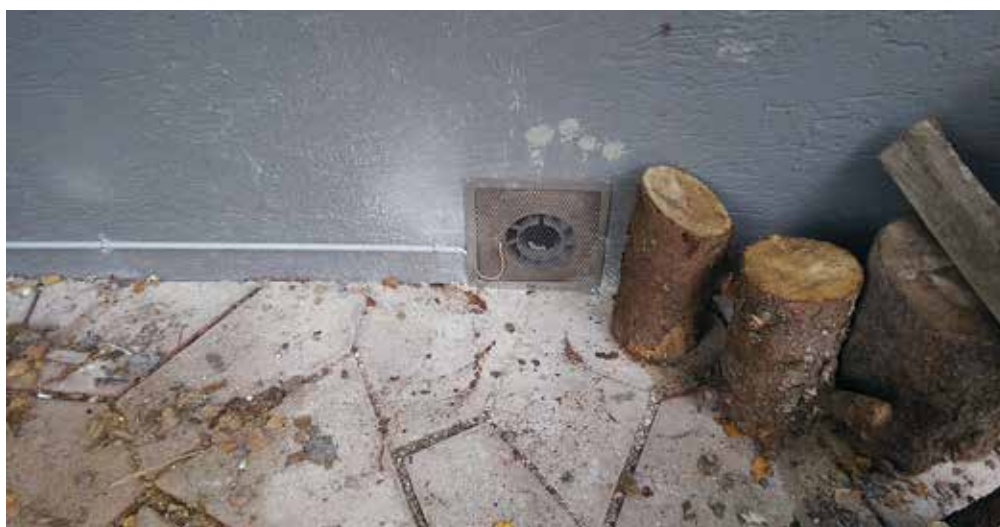
Figura 6.56: Esecuzione definitiva del pozzo radon.
