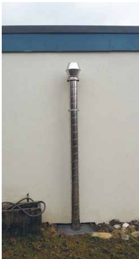
Figura 6.65: Nel vespaio è stato installato un impianto di aspirazione.
