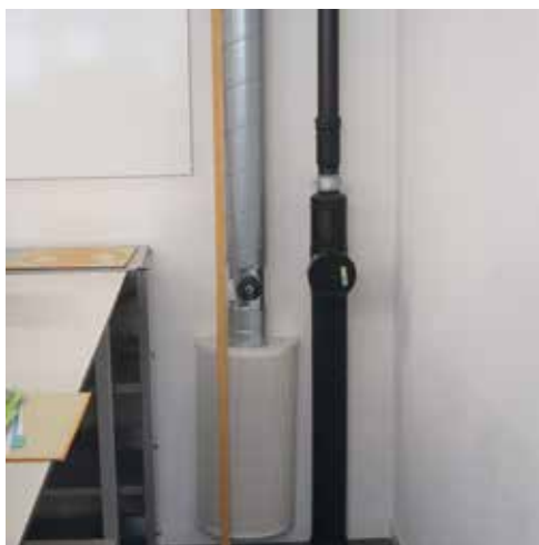
Figura 6.74: Diffusore per l'immissione d'aria di ventilazione (sinistra), regolazione del volume del flusso d'aspirazione (destra).
