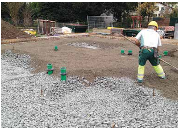
Figura 6.98: Breccia sotto la platea di fondazione funge da strato di livellamento.
