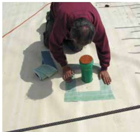
Figura 4.14 (destra): Dettaglio di sigillatura di una condotta passante prima del getto della soletta in cemento (Fonte: Sika).
