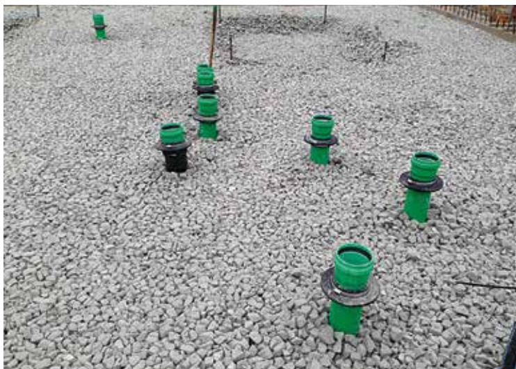
Figura 6.97: Uno strato di ghiaia in vetroschiuma funge da drenaggio radon.
