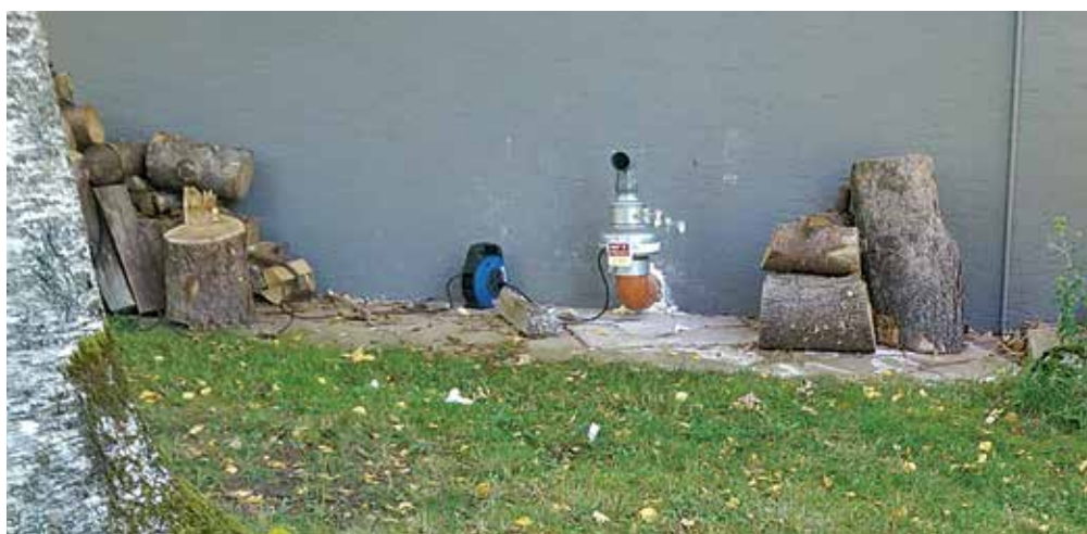
Figura 6.55: Installazione provvisoria del pozzo radon.
