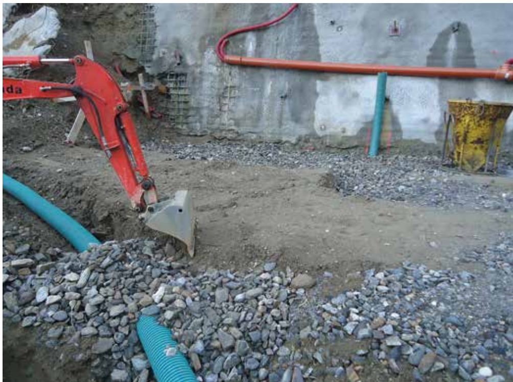
Figura 6.85: Installazione del sistema di drenaggio radon.
