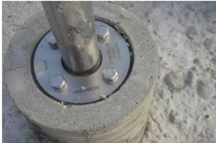
Figura 6.100: Una condotta passante ermetica al radon.
