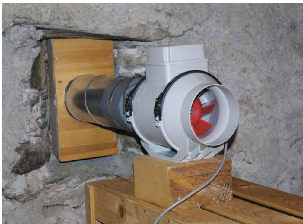
Figura 6.39: Mediante l'ausilio di un ventilatore l'aria del piano interrato viene trasportata all'esterno. L'aria con un'elevata concentrazione di radon non può quindi più concentrarsi all'interno dell'edificio.
