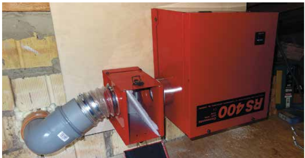
Figura 6.23: Per ragioni di spazio e per prevenire rumori nella zona notte, il tubo di ventilazione è stato installato esternamente all'edificio.
