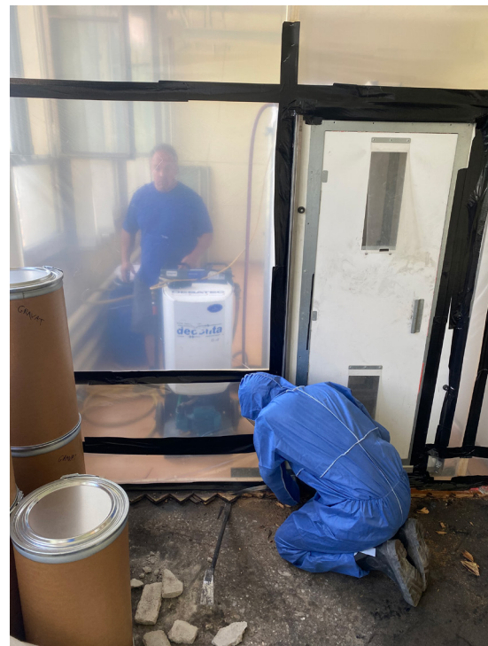
Figure 23 : Assainissement d'une ancienne fabrique horlogère contaminée au radium et aux hydrocarbures aromatiques polycycliques (HAP)
