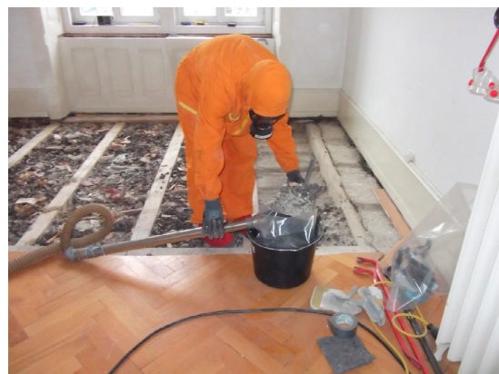
Figure 19 : Assainissement lié au radium dans une habitation
