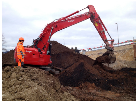
Figure 22 : Surveillance radiologique lors de travaux d'excavation dans une ancienne décharge susceptible de contenir des déchets au radium.
