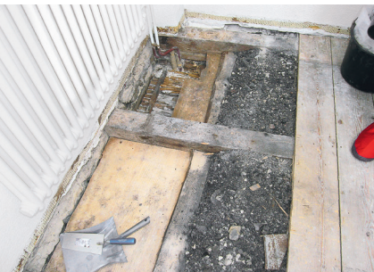
Fig. 18 : Vieux plancher en bois et gravats intermédiaires (noir)
