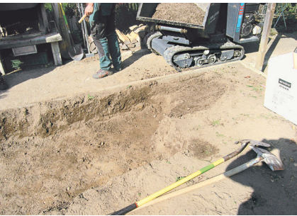
Fig. 19 : Assainissement d'un jardin contaminé au radium
