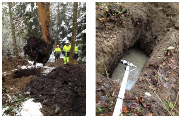
Figure 4a (gauche) et 4b (droite): Fouille lors d'un sondage et mesure dans une tranchée d'excavation à l'aide d'une sonde de mesure de la contamination.
