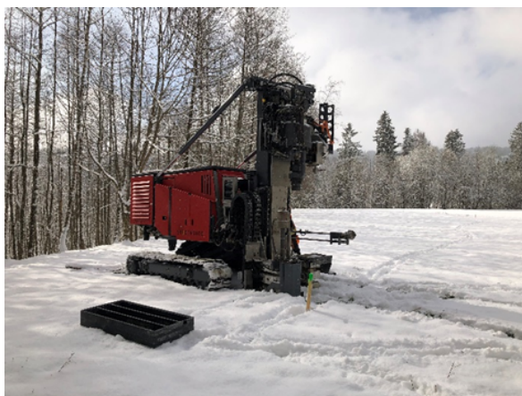
Figure 2 : Exemple de sondage par forage. Tout matériel contaminé par le radium doit, si possible, être remis dans le trou de forage.
