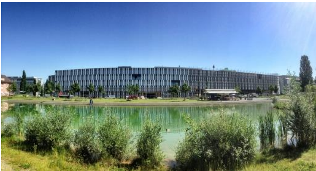
Sicht auf BAG Gebäude vom Liebefeld Parksee, Foto Thomas Steffel
