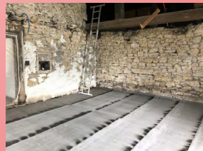
Posa di sola membrana antiradon sul pavimento senza coesione alle pareti e/o posa sulle pareti
