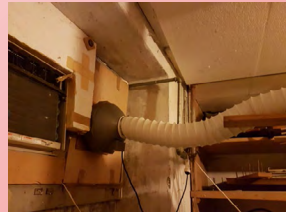
Perdita di portata nel sistema di ventilazione (curve, condensa, etc)
