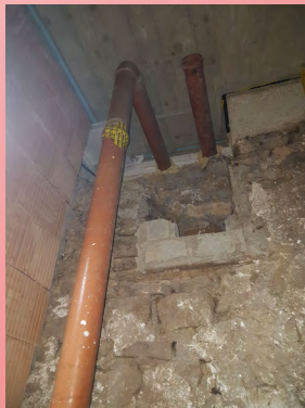
Sistema di drenaggio nell'edificio non equipaggiato con un ventilatore
