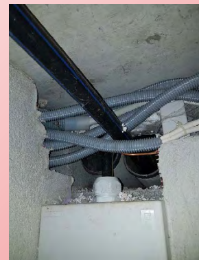
Presenza di punti di infiltrazione nell'edificio del radon
