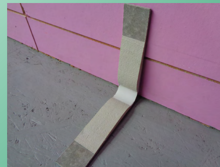
Posa di membrana antiradon in corrispondenza del raccordo pavimento-parete
