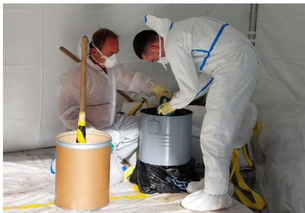
Figura 13: Imballaggio di terreni fortemente contaminati da radio in vista del loro trasporto al centro federale di raccolta
