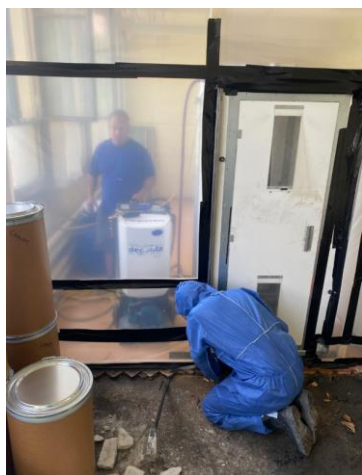
Figura 11: Lavori di decontaminazione in un appartamento
