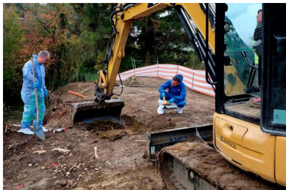
Figure 12: Controllo finale di verifica del successo della decontaminazione da parte dell'UFSP (fonte: Hanna Girard)
