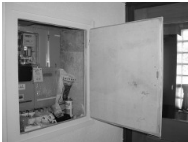
Scatola dei fusibili con lastra antincendio all'amianto sulla porta interna, foto: IST
