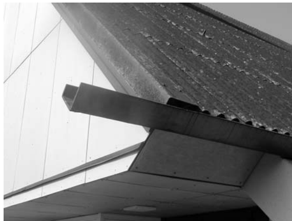
Lastre ondulate in fibrocemento amiantoso, foto: IST
