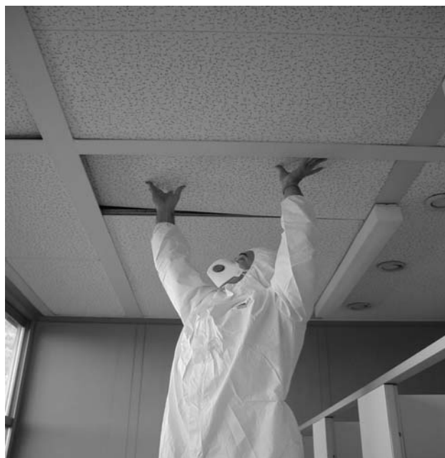
Pannello da soffitto sganciato (pannello fonoassorbente), foto: IST
