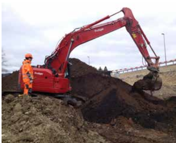
Figure 3 : Surveillance radiologique lors de travaux d'excavation dans une ancienne décharge susceptible de contenir des déchets au radium.
