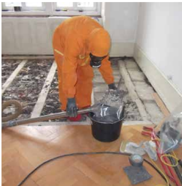
Figure 1 : Assainissement lié au radium dans une habitation.
