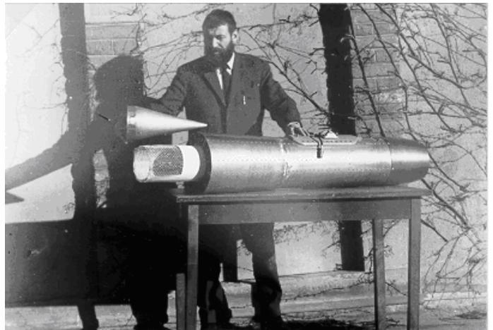
**Figur 1: Paul Winiger mit dem von den damaligen Flugzeugwerken in Emmen gebauten Sammelgerät für Aerosolproben aus der oberen Troposphäre bzw. der unteren Stratosphäre. Der Filter wird um einen Zylinder aus Drahtgitter gelegt (links sichtbar) und radial von innen nach aussen durchströmt. Lufteinlass ist rechts, Luftauslass links.**
