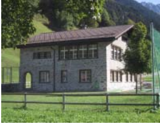
Figur 10 Schulgebäude im Kanton Graubünden
