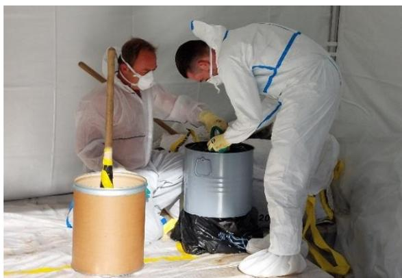
**Figure 13** : Conditionnement de terres fortement contaminées au radium en vue de leur transport au Centre fédéral de ramassage
