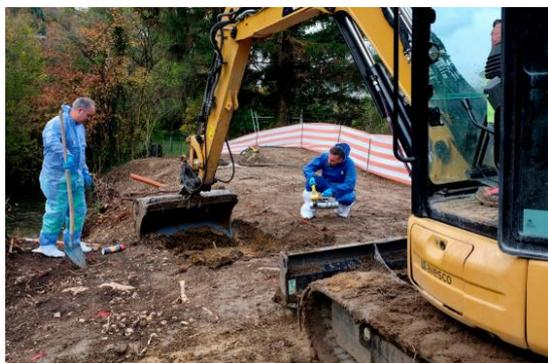
**Figure 12** : Contrôle final de l'OFSP afin de vérifier le succès de la décontamination (source : Hanna Girard)
