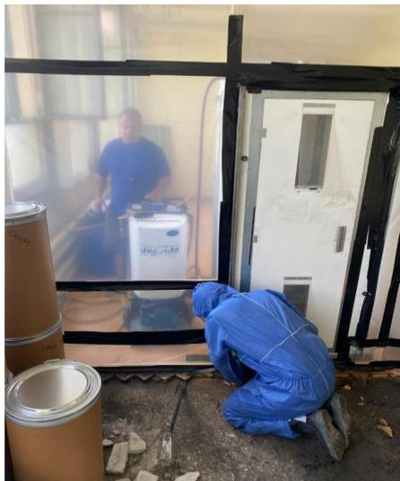
**Figure 11** : Travaux de décontamination dans un appartement
