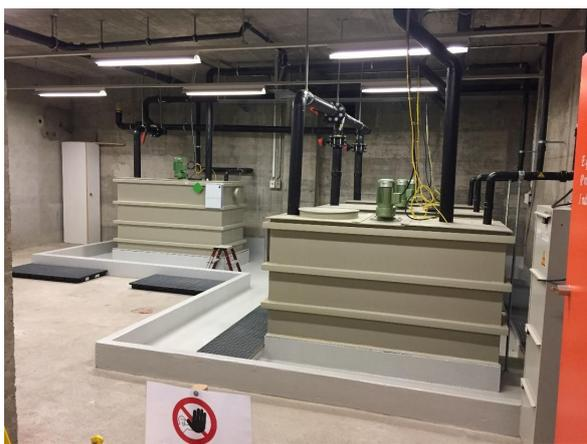
**Figure 9 :** Cuves de décroissance des eaux usées issus de chambres de thérapies
