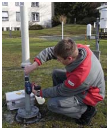
Figur 6: Alte Sonde wird ausgebaut.
