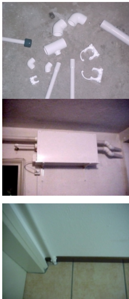
Figure 13: Vues de détails du système d'assainissement par mise en dépression de la cave
