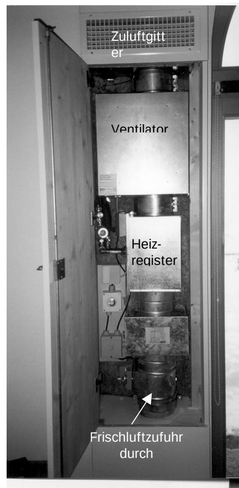
Figur 11: Zuluftanlage mit Luft von Heizung
