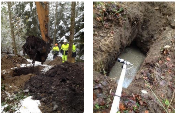
Abbildung 4a (links) und 4b (rechts): Sondierungsgrabung und Messung in einem Sondierungsgraben mit einer Kontaminationsmesssonde.
