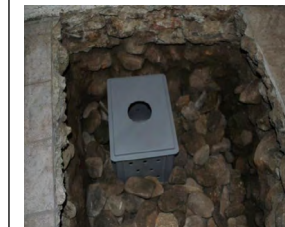
Brunnen für die Radonabsaugung aus dem Boden
