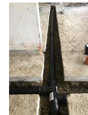
Verlegung von Absaugungs- und Drainerohren für Radon
