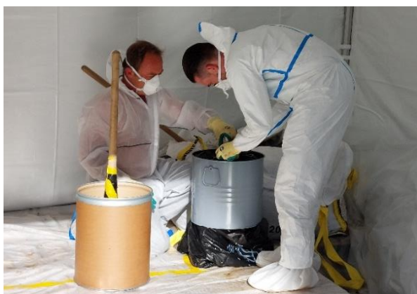
Abbildung 13: Konditionierung von stark mit Radium kontaminierter Erde für den Transport zum Bundeszwischenlager (BZL)
