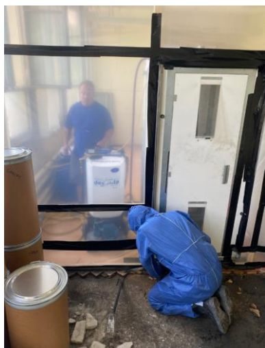
Abbildung 11: Dekontaminationsarbeiten in einer Wohnung
