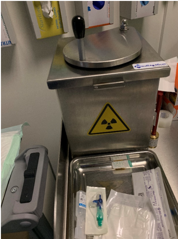
Abbildung 7: Abgeschirmte Behälter für die aktivsten Abfälle in der Nuklearmedizin
