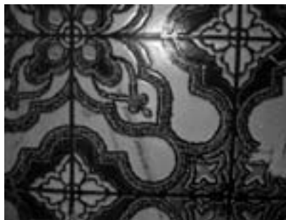
Revêtement de sol à trois couches, dont la couche inférieure est composée d'un carton d'amiante
